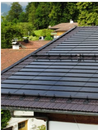
Nelskamp Doppelmuldenfalzziegel mit Nelskamp PV-System.
