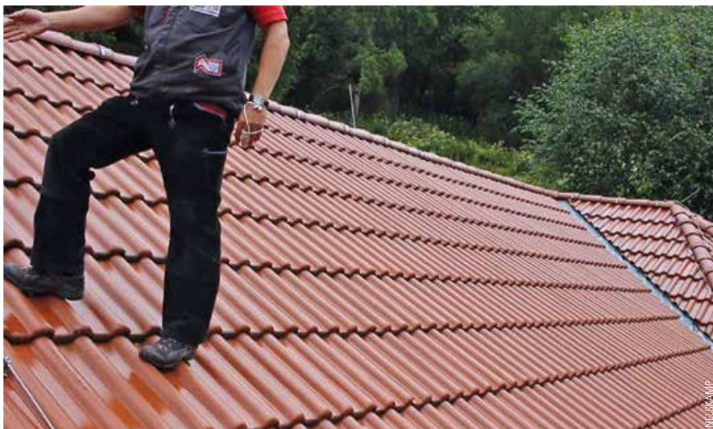
Der »Nibra-DS 5« ist seit 14 Jahren härtestem Harz-Wetter ausgesetzt und leuchtet nach einem sommerlichen Regenguss 2018 in frischem Rot.
