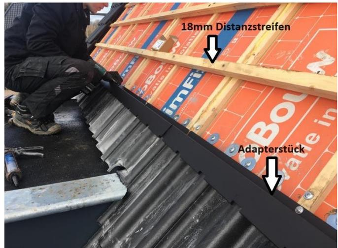
Die Planum PV Module werden idealerweise in Spalten von unten nach oben verlegt. Bei Walmdächern erfolgt die Verlegung von rechts unten nach links oben.
