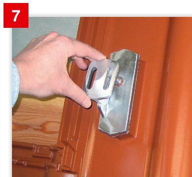
7 Anschließend den montierten Solarträgeraufsatz nach Dachneigung ausrichten.
