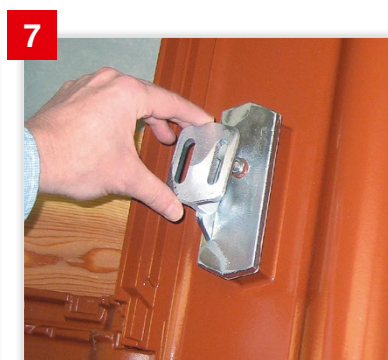
7 Anschließend den montierten Solarträgeraufsatz nach Dachneigung ausrichten.
