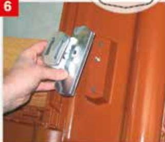
Jetzt kann der Solarträgersatz mit der Trägerpfanne verschraubt werden.
