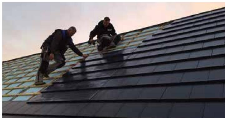
Jeglicher Schattenwurf von Bäumen, Masten, Kaminen etc. auf die Module verringert die Leistungsfähigkeit der Module. Die Auslegung des Systems sollte so gestaltet sein, dass es nicht oder nur unwesentlich dadurch beeinflusst wird.
