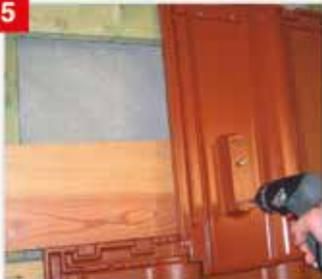
Die Alu-Solar-Trägerpfanne mit zwei Edelstahlschrauben in die Holzbohle befestigen. Die Länge der Schrauben ist bauseits zu bestimmen. Die Trägerpfanne hat keinen direkten Kontakt zur Holzbohle.
