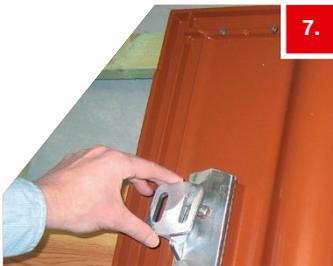
Anschließend den montierten Solarträgeraufsatz nach Dachneigung ausrichten.
