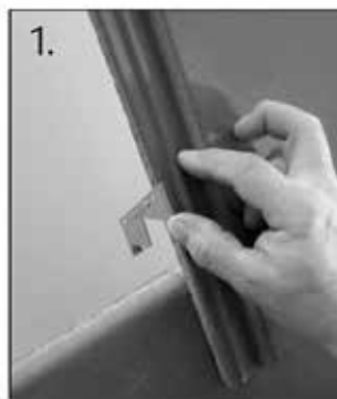
1. Klammer auf Seitenfalz setzen.
