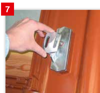
7 Anschließend den montierten Solarträgeraufsatz nach Dachneigung ausrichten.
