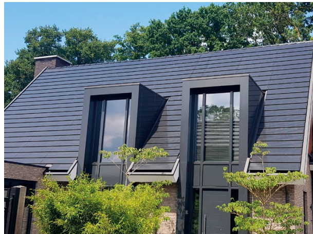
G 10 S PV Solardach.
