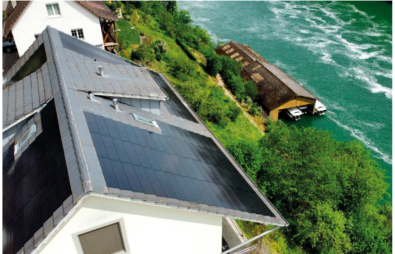
G 10 S PV mit G 10 in anthrazitgrau engobiert, Sanierung: ca. 50 m 2 bestehende Ziegel ausgedeckt und mit G 10 S PV Module eingedeckt.
